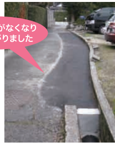
道路補修工事
