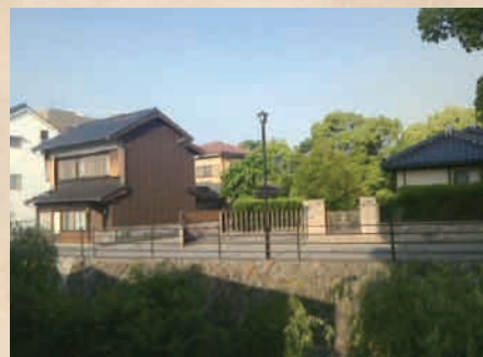
山口御茶屋跡(中河原町)の様子 当初、山口御茶屋は、藩の公館として、参勤交代・国内巡行などに使用するための宿泊施設として建てられました。
